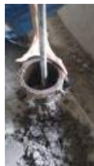
Gambar 3.16. Pemadatan Beton Segar
